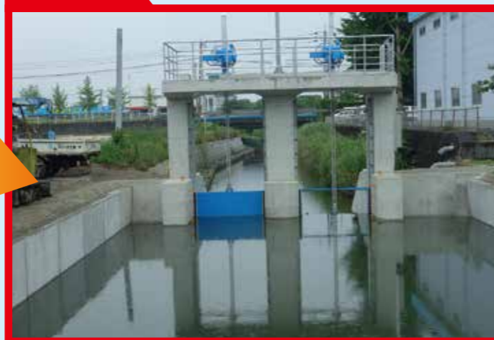
極楽橋樋門(西湊) 2.2m×2
