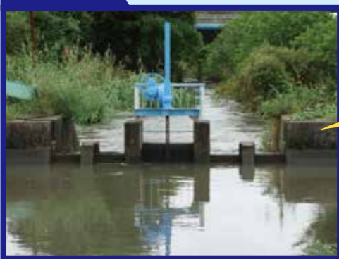
極楽橋樋門(西湊) 下村雨水幹線国道34号線北
