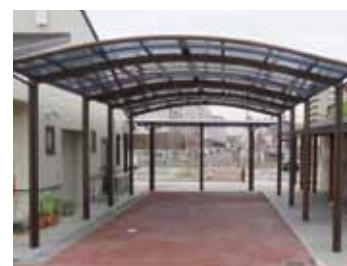
完成した大屋根
